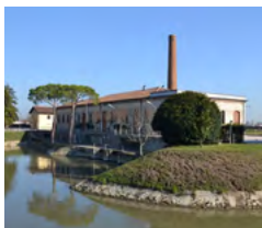
Idrovora di S. Margherita via Idrovora, 13 Codevigo (Pd)
